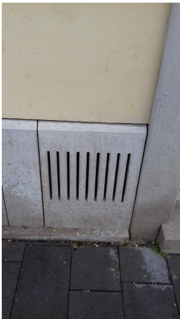
Obr. č. 7: Vysekanie otvoru vo fasádnom obklade v mieste odvetrávacích otvorov, osadenie vetracej mriežky – 3 ks
