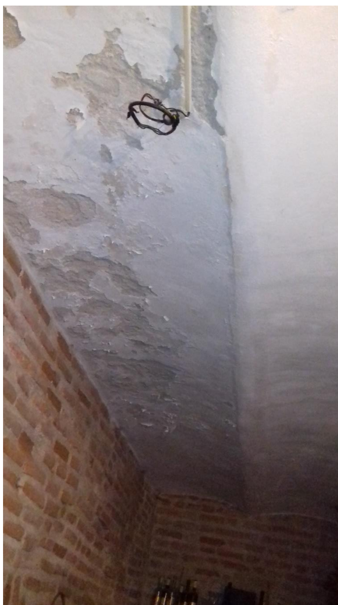
Obr. č.8: Strop vo vinárskom spolku – osekanie omietok, náter kovových nosníkov, sanačný systém
