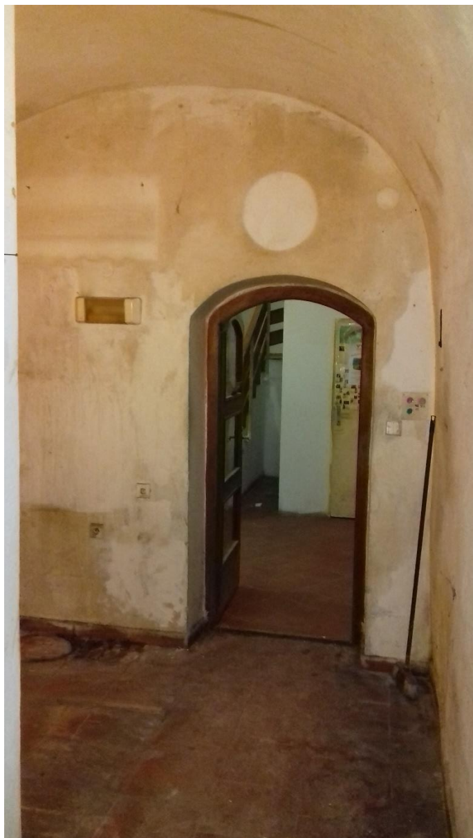
Obr. č.4: Demontáž ventilátora a osadenie vetracej mriežky v interiéri namiesto neho
