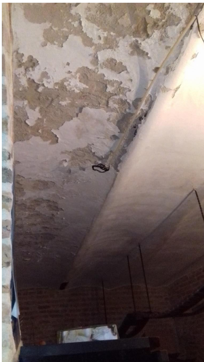
Obr. č.8: Strop vo vinárskom spolku – osekanie omietok, náter kovových nosníkov, sanačný systém
