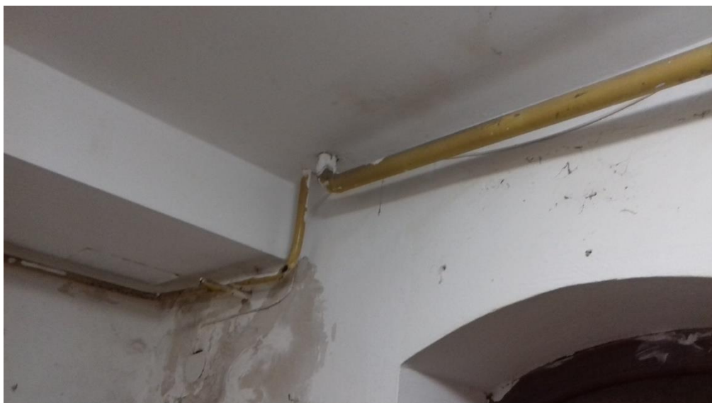
Obr. č. 10: Stena v suteréne – osekávanie omietok, nanosenie sanačnej omietky
