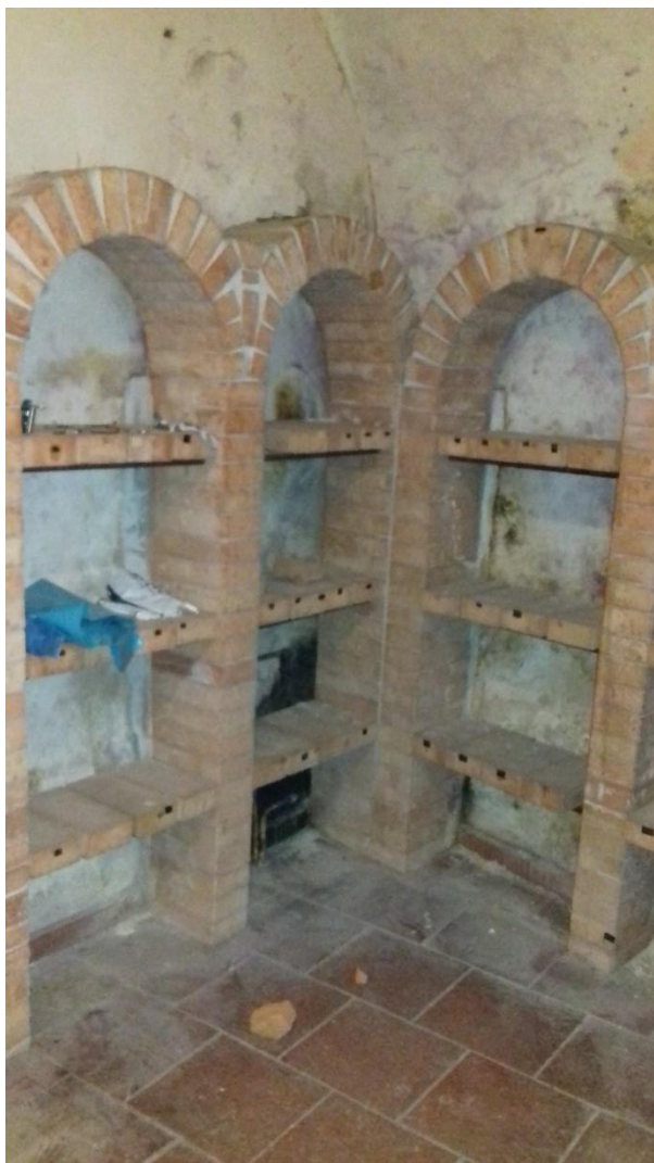
Obr č.5: Demontáž tehlových políc vo vinárni
