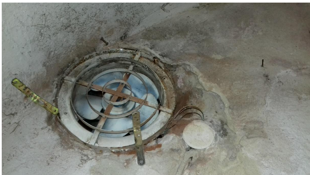
Obr. č.4: Demontáž ventilátora a osadenie vetracej mriežky v interiéri namiesto neho
